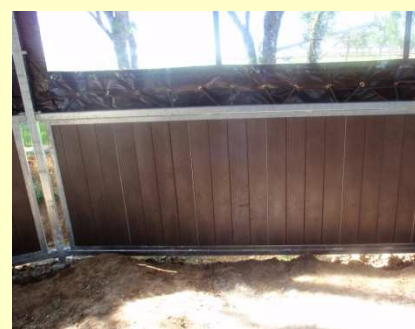
• Pare bottes en PVC recyclé imputrescible (en option)
