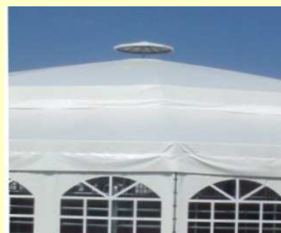
Aération par lanterneau manœuvrable depuis le sol
