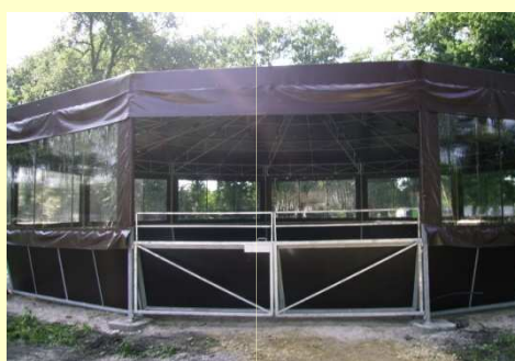
• Porte d'accès et pare bottes en contreplaqué marine traité double face
